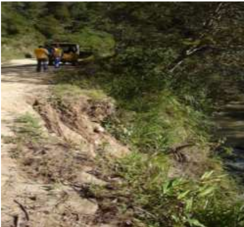
MURO CONCRETO PR 48 + 200
