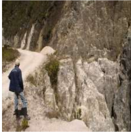
Figura 4 PR 55 + 320 socavación ladera
