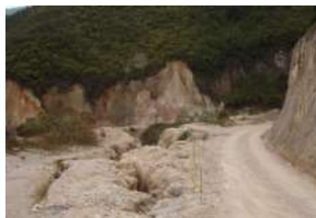
Figura 7 PR 56+180 Socavación
