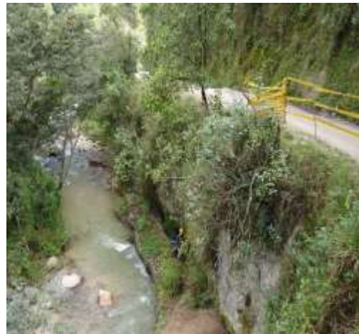
MURO CONCRETO PR 57 + 250
