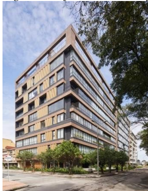
Figura 7 Edificio Kubik Virrey
