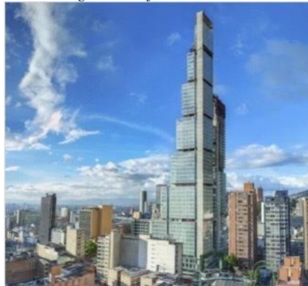
Figura 6 Edificio BD Bacatá
