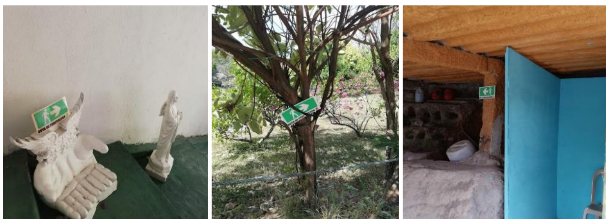
Figura 15. Falta de señalización de la Ruta de evacuación en caso de emergencia.
