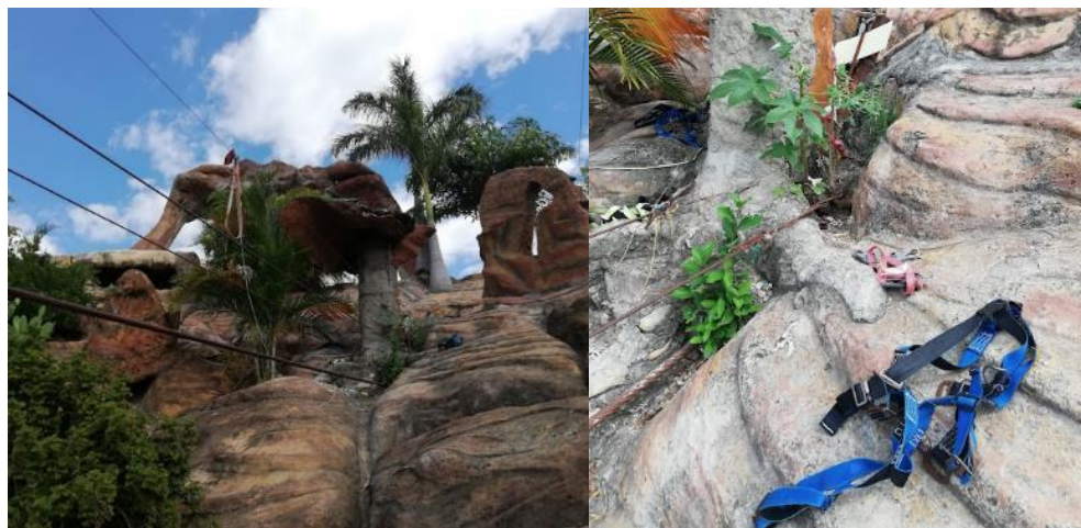
Figura 17. Disposición y almacenamiento incorrecto de equipos de protección contra caídas
