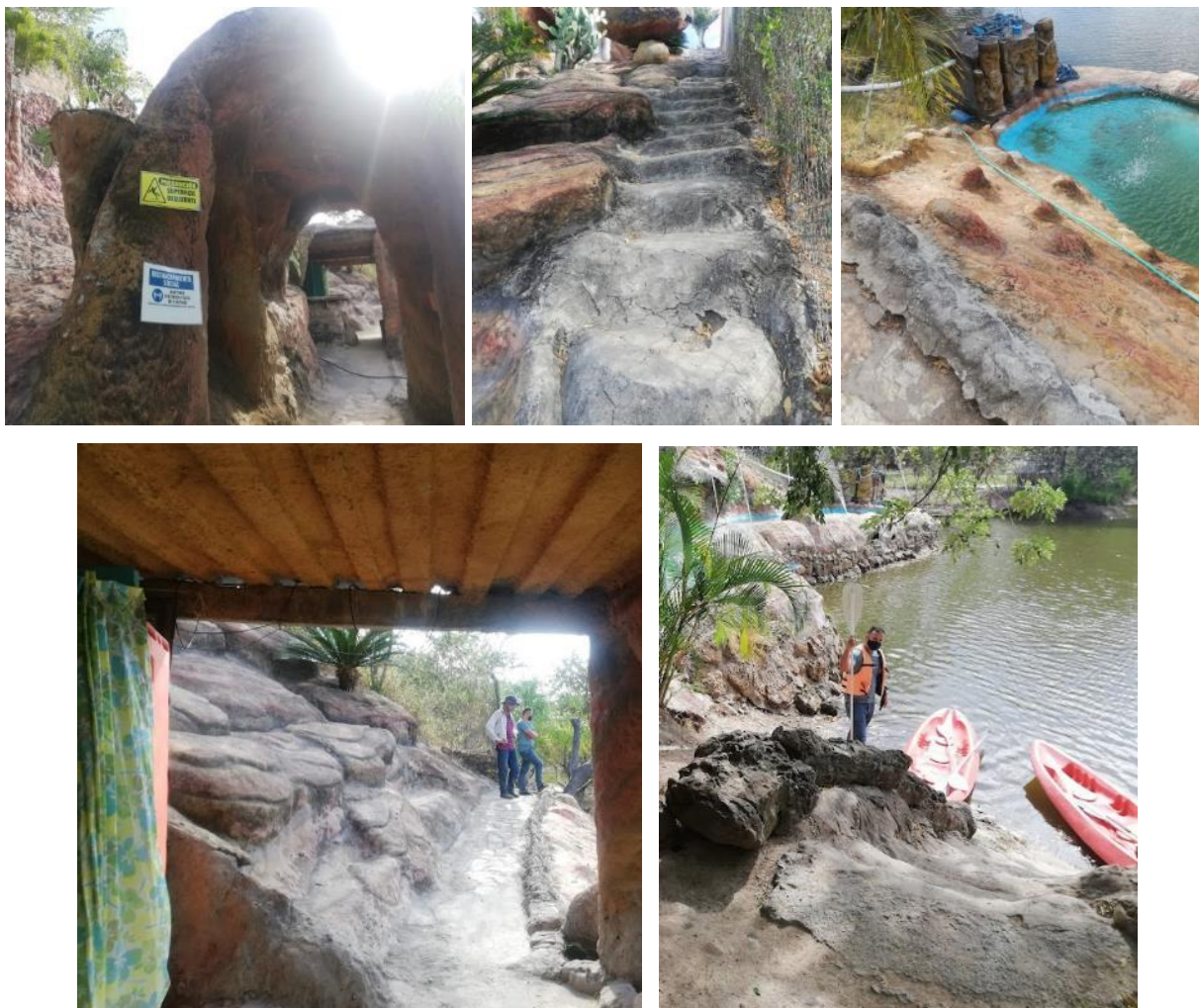
Figura 13. Superficies deslizantes en mal estado
