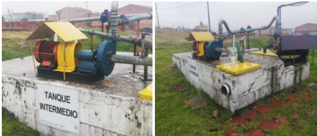
Figura 8. Inspección de campo
