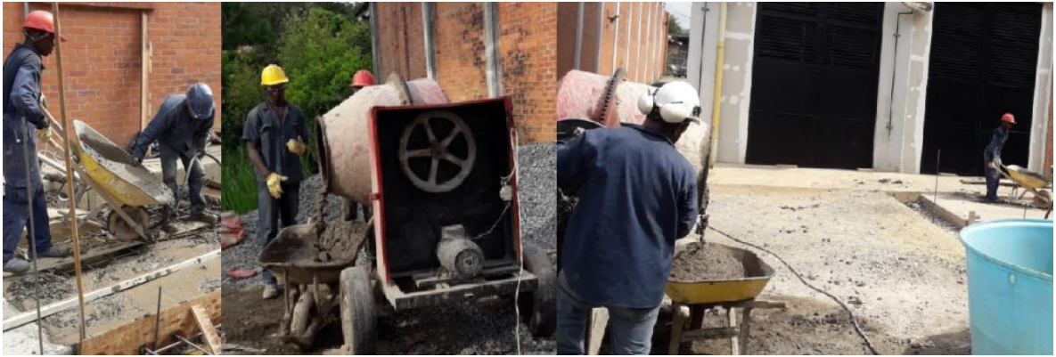
Figura 15. Aprovechamiento de mezclador de cemento para concreto y buggy
