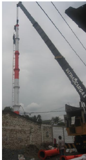
Figura 14. Aprovechamiento de Grúa telescópica HP
