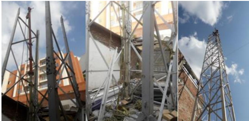
Figura 11. Aprovechamiento de Pluma con Poleas y cuerda
