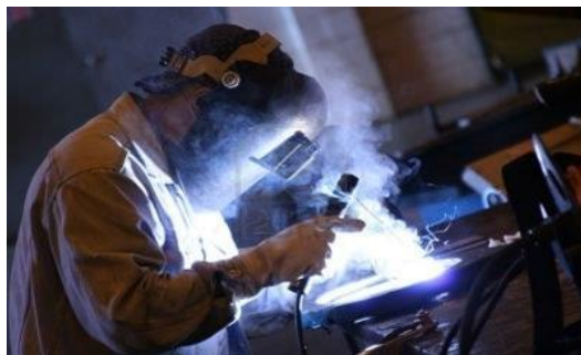
Imagen 4. Humos De Soldadura
