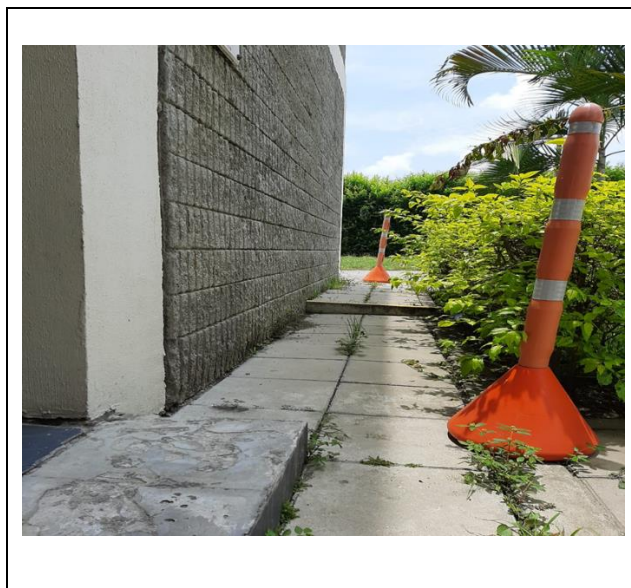
Figura 6 Fotografía zona lateral Centro de Control Aeropuerto
