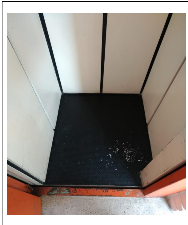
Figura 8 Fotografía vista del interior del ascensor de la Torre de Control
