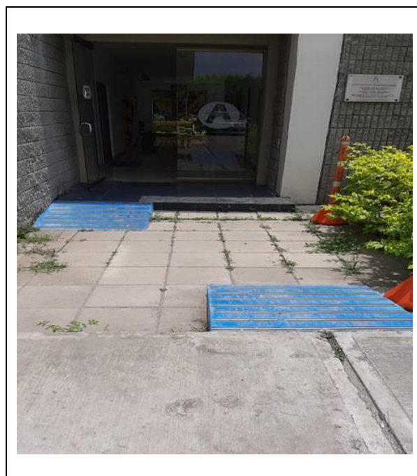
Figura 5 Fotografía zona de salida centro de Control Aeropuerto
